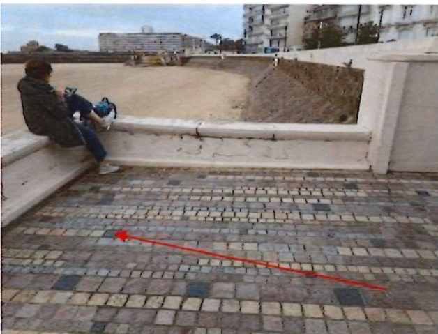
Altération et fissures diverses au droit du muret en béton - zone devant la piscine (à gauche) / Fissures et fractures colmatées au droit du muret en béton - zone devant le bâtiment (à droite)
