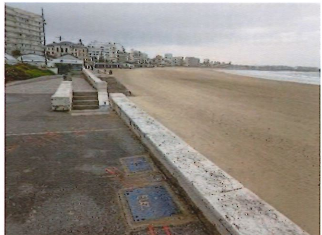
Altération et fissures diverses au droit du muret en béton - zone devant la piscine (à gauche) / Fissures et fractures colmatées au droit du muret en béton - zone devant le bâtiment (à droite)
