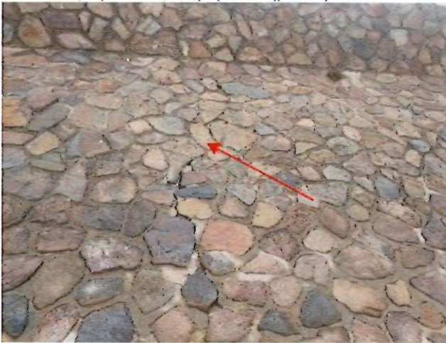
Fissure verticale au droit des joints au mortier sur toute la hauteur du perré (à gauche) / Fracture horizontale
