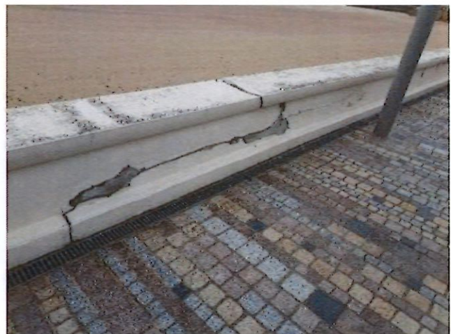
Altération et fissures diverses au droit du muret en béton - zone devant la piscine (à gauche) / Fissures et fractures colmatées au droit du muret en béton - zone devant le bâtiment (à droite)
