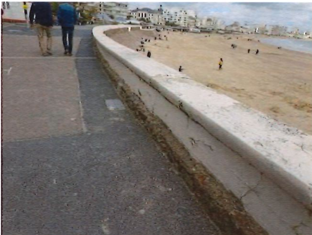
Altération et fissures diverses au droit du muret en béton - zone devant la piscine (à gauche) / Fissures et fractures colmatées au droit du muret en béton - zone devant le bâtiment (à droite)
