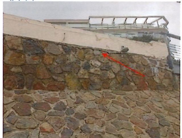
Fissure verticale au droit des joints au mortier sur toute la hauteur du perré (à gauche) / Fracture horizontale
